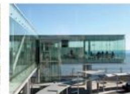
自由通路と一体となった眺望を 活かしたカフェ
